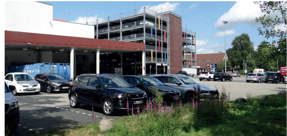
Abb. Parkhaus Marktcenter - Hansestadt Uelzen
